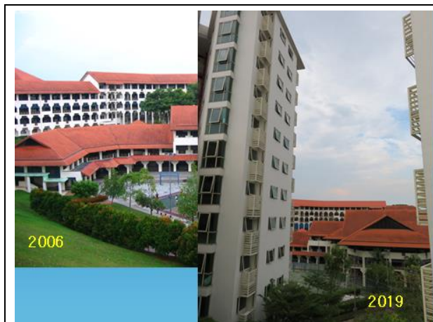
国際学校の建物が大きくせり出していた
