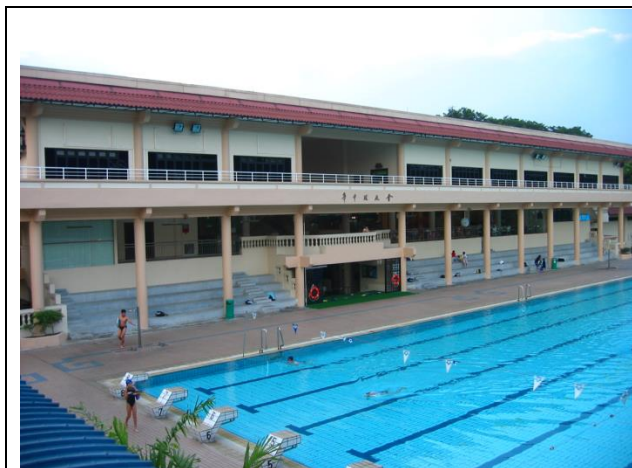
2006 年には立派なプールとレストランがあった
